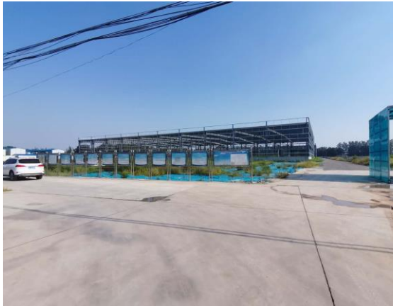
在建项目现状:
